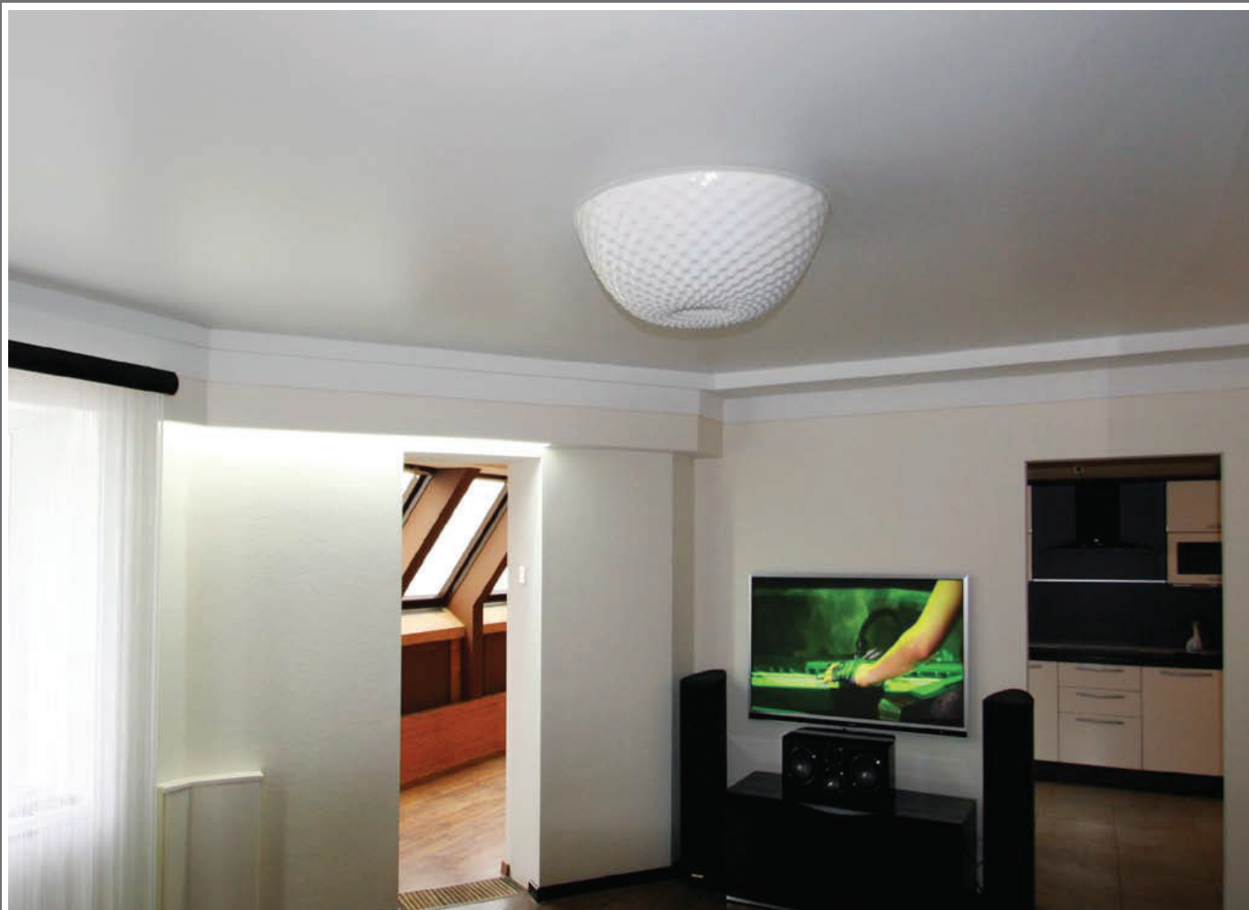
SOFFITTO TESO MICROFORATO CON FUNZIONE DI FONOASSORBENZA
