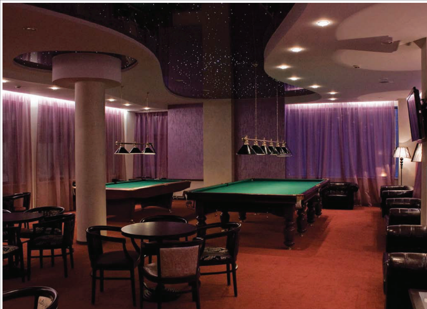
SOFFITTO TESO CIELO STELLATO CON FIBRA OTTICA COMBINATO CON SOFFITTO IN CARTONGESSO
